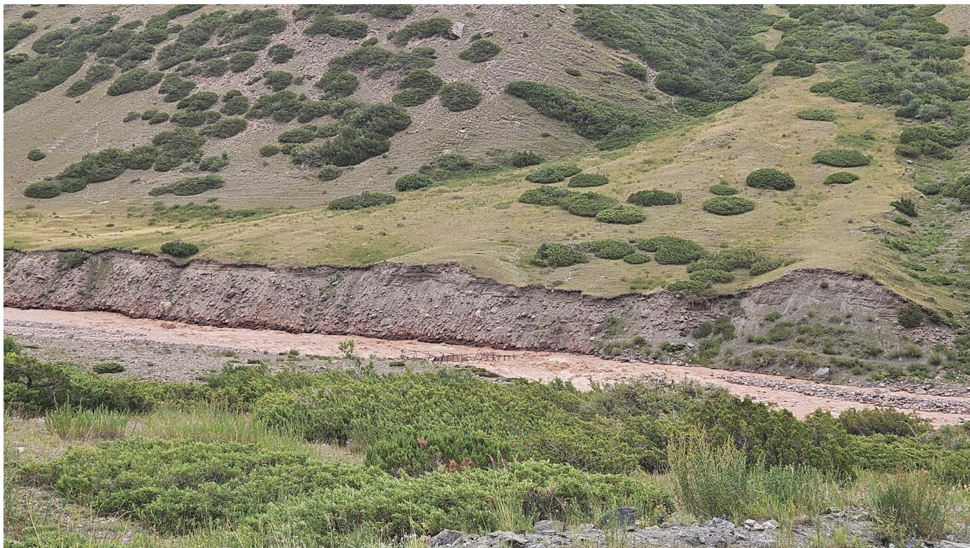
Фото 4.7. Разрушенный мост через Нуру
