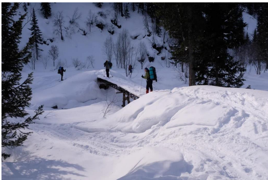
Фото 12-1. Мост через р. Амзас.
