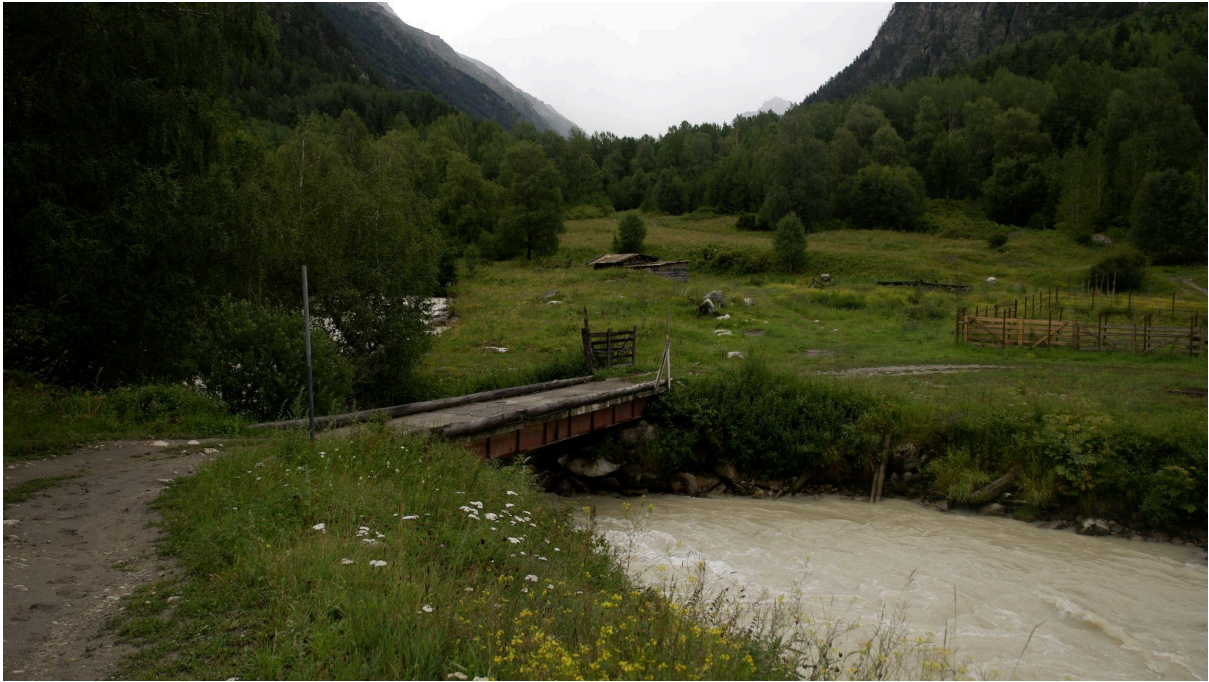
Автомобильный мост через р. Кубань.
