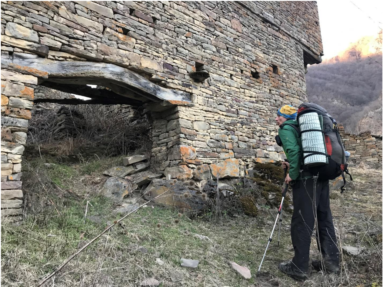
Рисунок 42 – Разрушающие постройки в селе Тама в Кайтагском районе Дагестана
