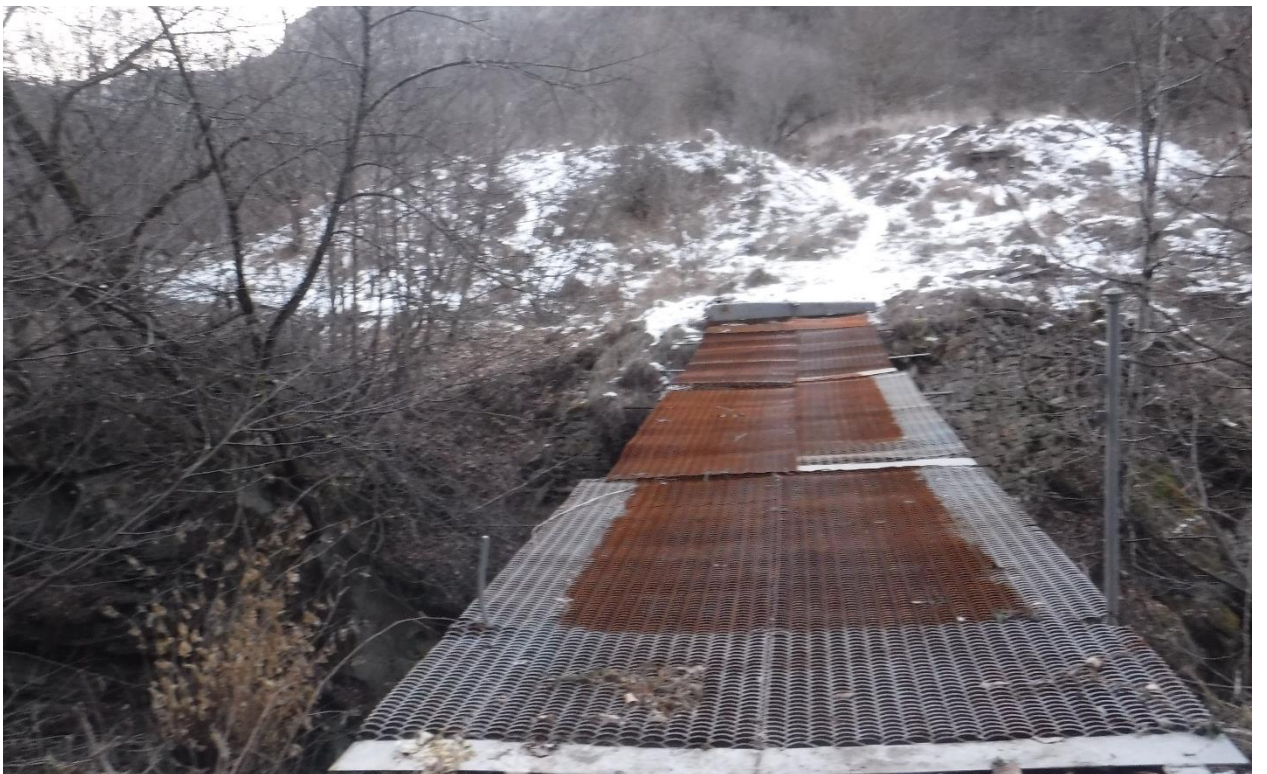
Рисунок 43 – Мост через р. Уллучай
