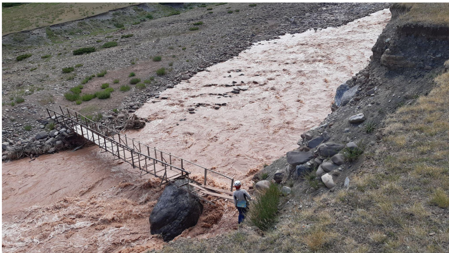
02.02. Восстановление моста через реку Нура
