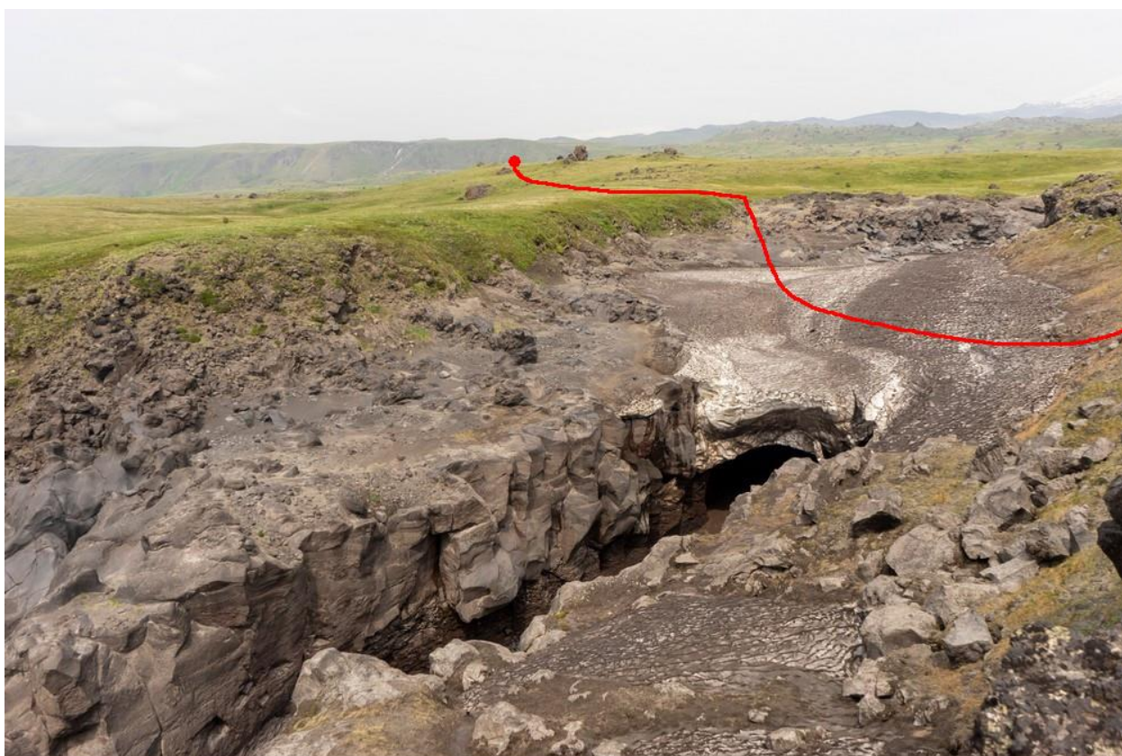
Фото 2.5 - снежный мост через Студёную
