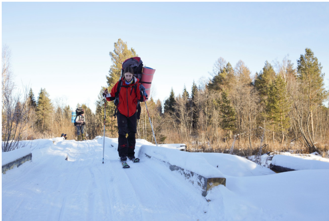
Фото 1. На мосту через р.Большой Каменный
