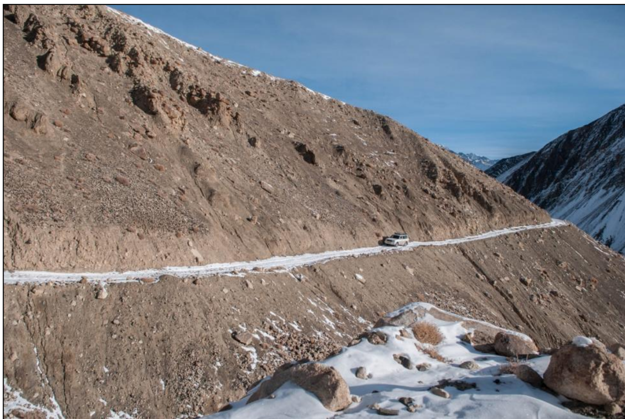
Рис. 49. Участок дороги в долине Элису
