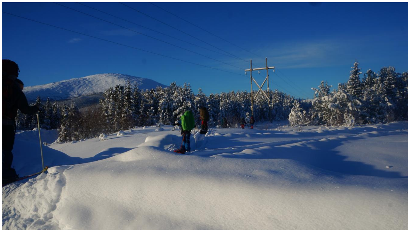
Рис. 21. ЛЭП от поселка Кытлым в направлении воинской части.
